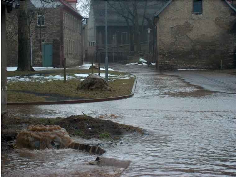
Abbildung 29: Überlastung eines Abwasserkanals bei extremen Niederschlägen
