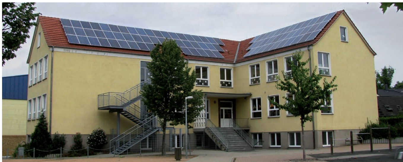
Das Dach der Grundschule Osterburg mit der Photovoltaik-Anlage. (Quelle beide Fotos: Hansestadt Osterburg)
