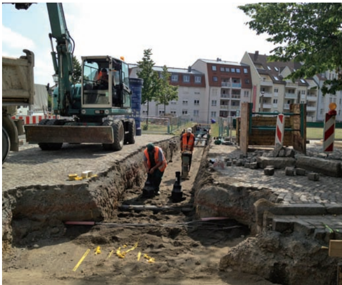
Der Trassenbau am Domplatz in Halberstadt. (Quelle: HALBERSTADTWERKE GmbH)
