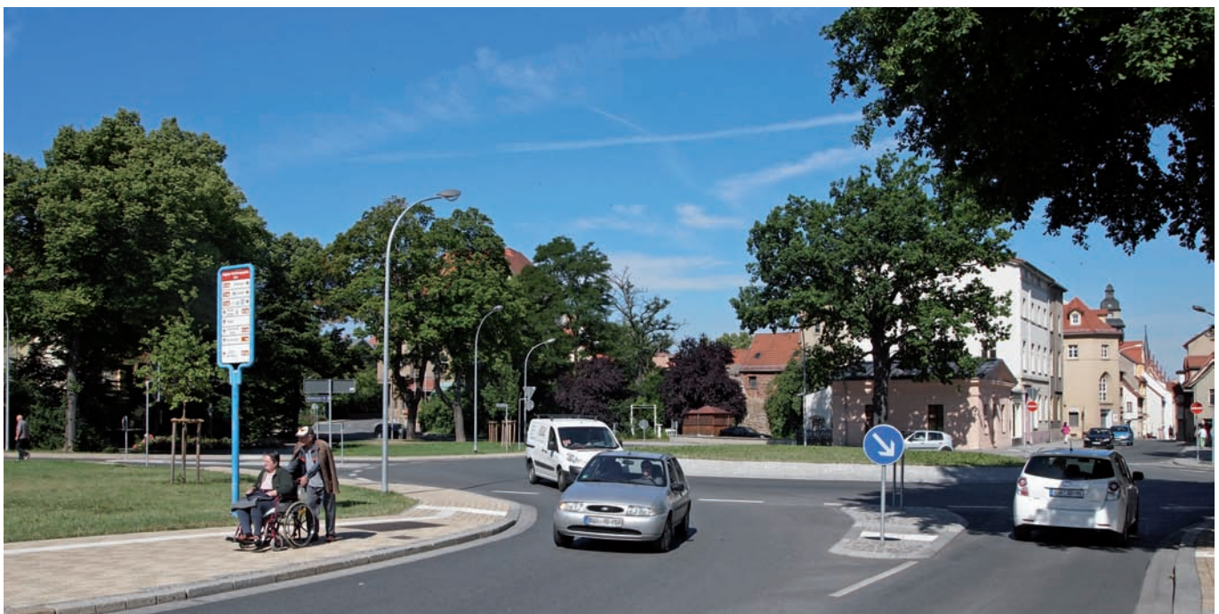
Nach dem Ausbau des damals unübersichtlichen Kreuzungsbereichs von fünf einmündenden Straßen zu einem barrierefreien Kreisverkehr wurden die Voraussetzungen zur Aufhebung der Einbahnstraßenregelung für drei Straßen geschaffen (August-Bebel-Str., Weberstr. und Altenburger Str.).
