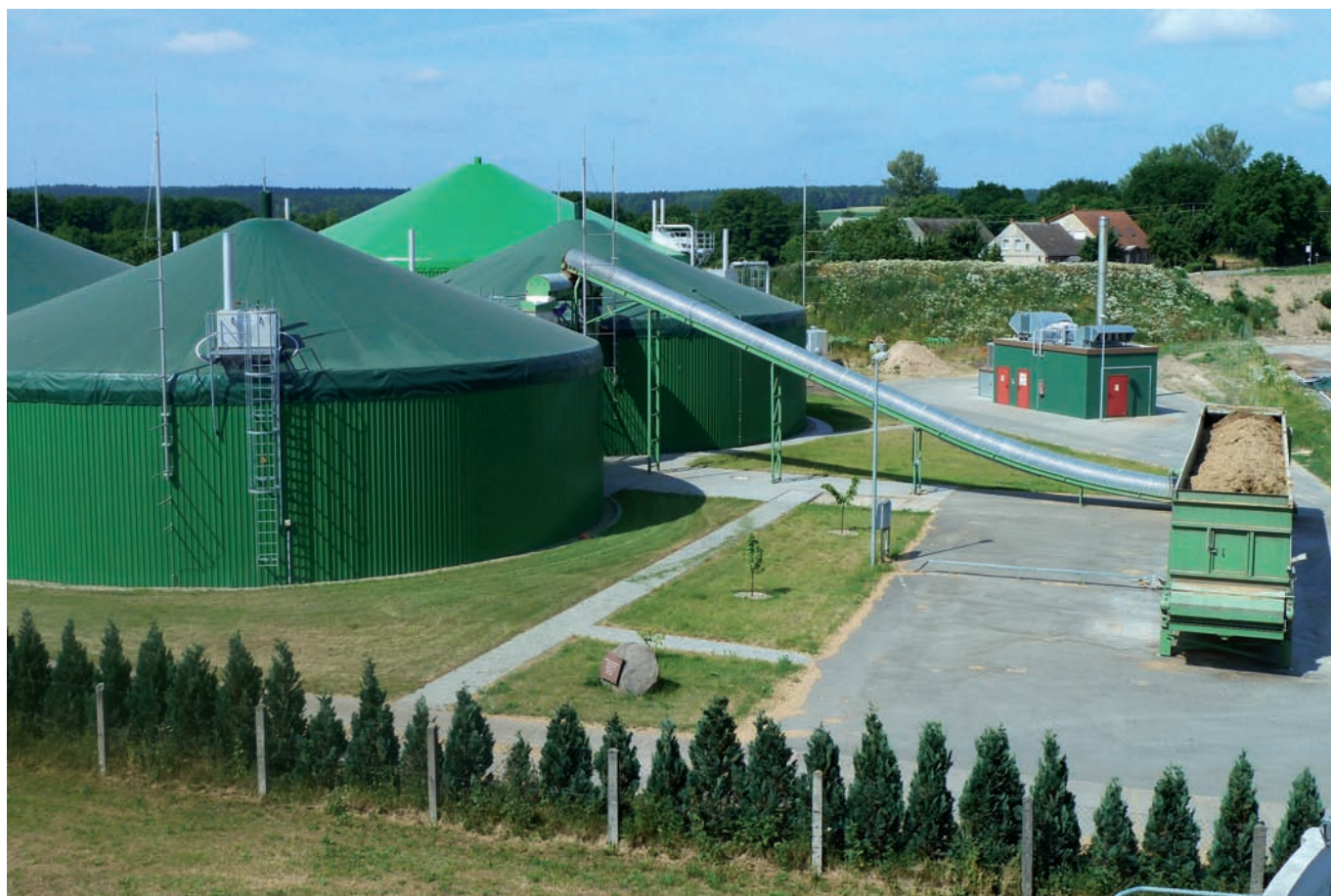
Biogasanlage in Tangeln. (Quelle: Landwirtschaftliches Unternehmen Tangeln eG)
