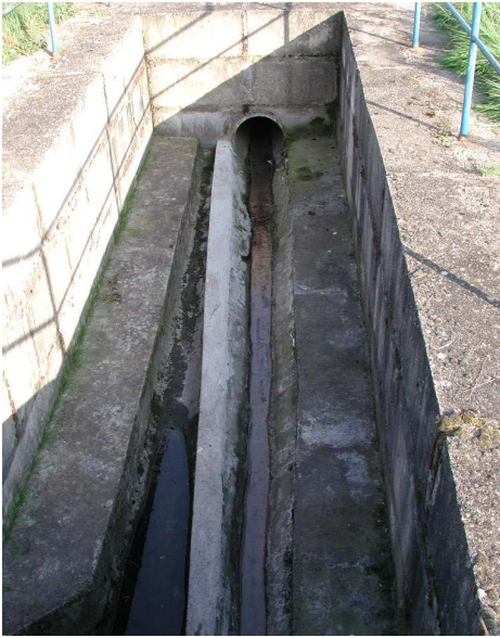
Bild 124: Zulaufbauwerk, Anlage Rietzel
