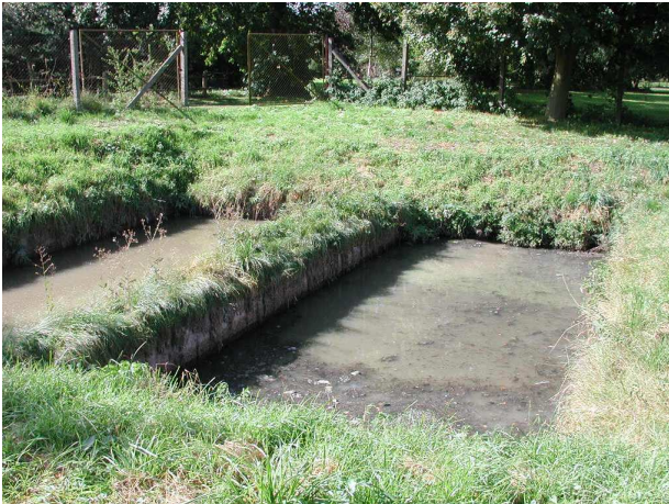
Bild 118: Absetzbecken, Anlage Tangeln
