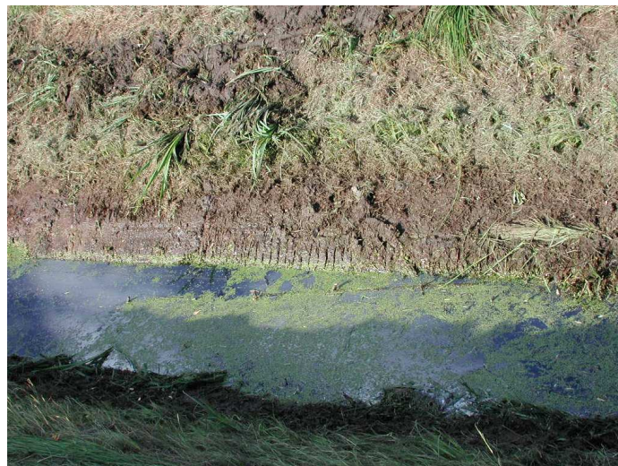
Bild 69: Ablaufgraben der Abwasserteichanlage Rietzel (15.09.2004)
