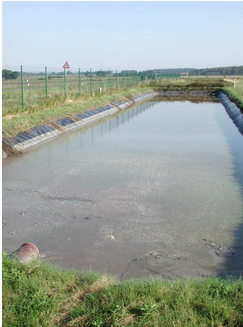
Bild 78: Teich 1 der Anlage Eickendorf
