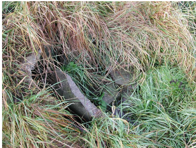
Bild 18: Beispiel für ein zerstörtes Ablaufbauwerk und unzureichende Vegetationspflege
