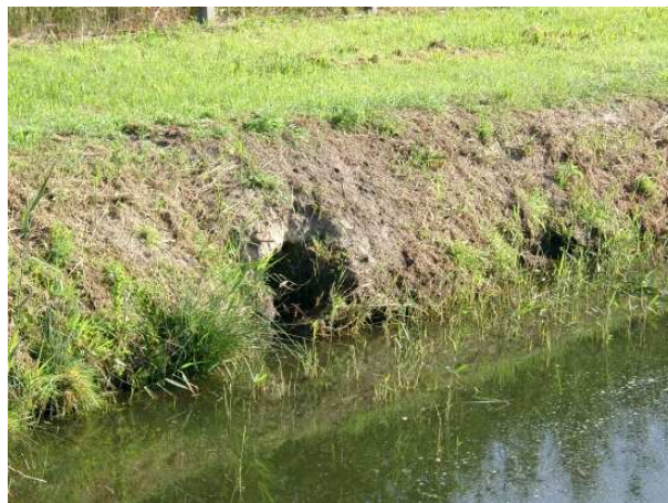
Bild 58: Grablöcher der Bisamratten, Abwasserteichanlage Dambeck (08.09.2004)
