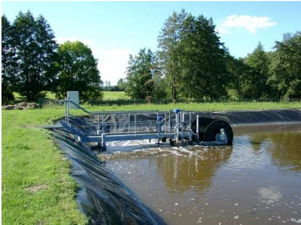
Bild 103: Belüftereinrichtung mit Walze auf Teich 1, Anlage Wallstawe
