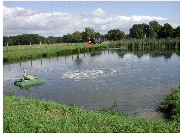
Bild 119: belüfteter Teich, Anlage Tangeln
