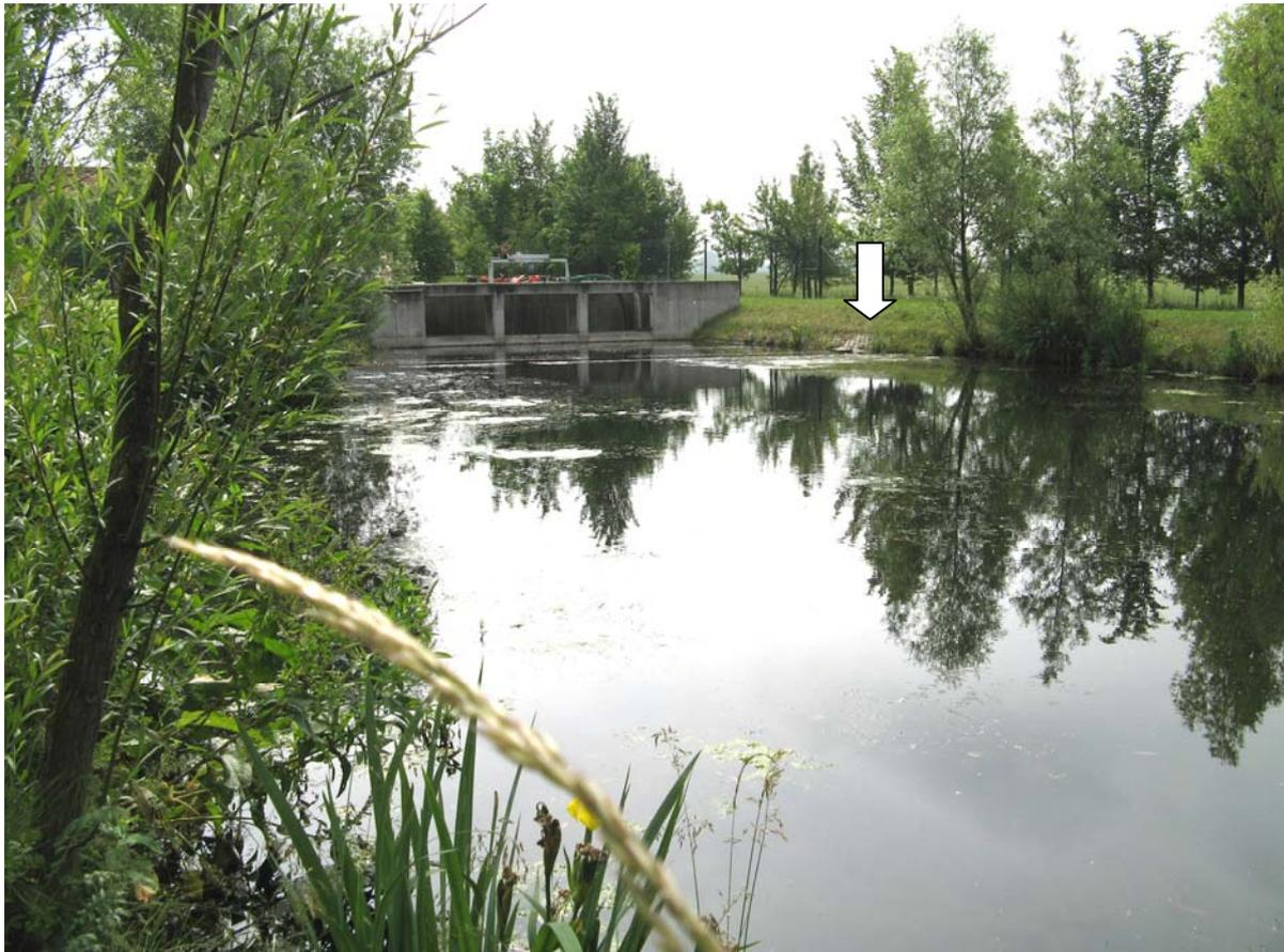
Bild 5: Nachklärteich (im Hintergrund Bereich, der mit *Eichhornia crassipes* besetzt wurde, Abschnittbeginn mit Pfeil gekennzeichnet bis Auslaufbauwerk)
