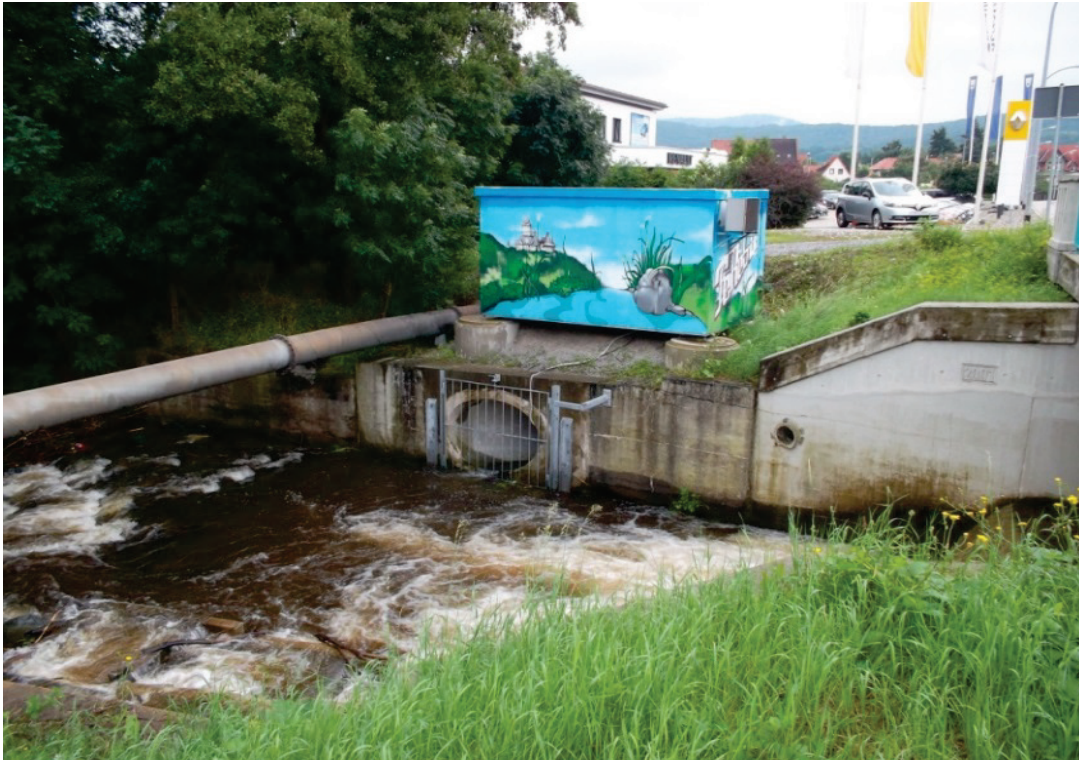
Abbildung 2: Regenwasserkanal und Messcontainer in der Schmatzfelder Straße (Foto: LAU)
