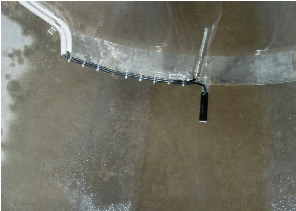
Abbildung 3: Ultraschall- und Drucksonde im Regenwasserkanal (Foto: LAU)
