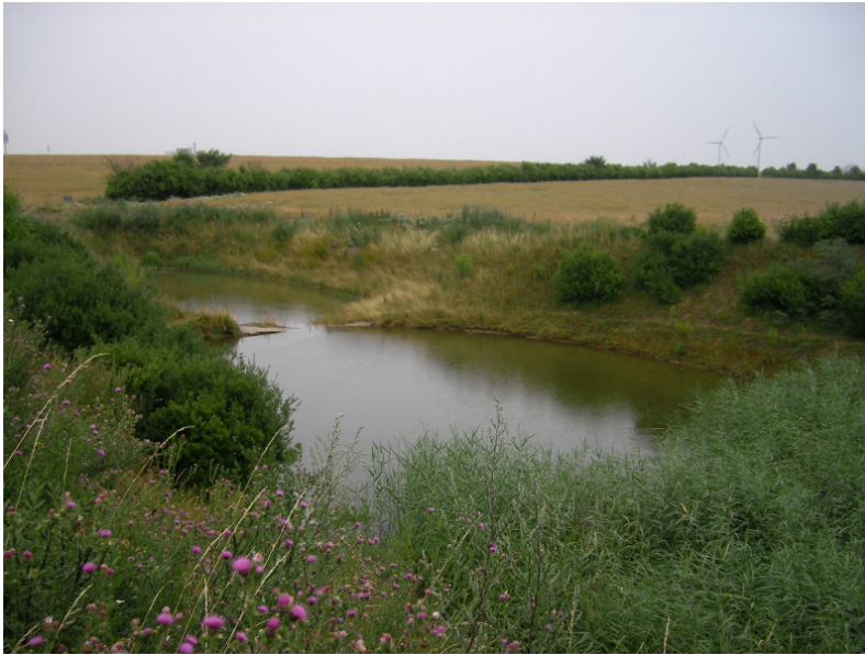
Überstautes Versickerungsbecken an der A9 nach längerer Trockenperiode
