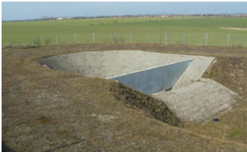
Zuflussfreies Absetzbecken an der B6n
