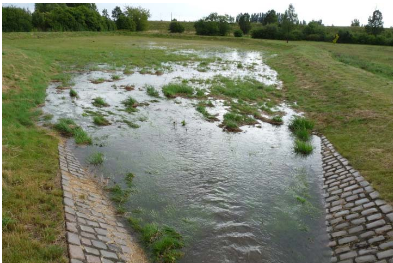
Befüllung des Versickerungsbeckens nach einem Starkregen (14 mm)
