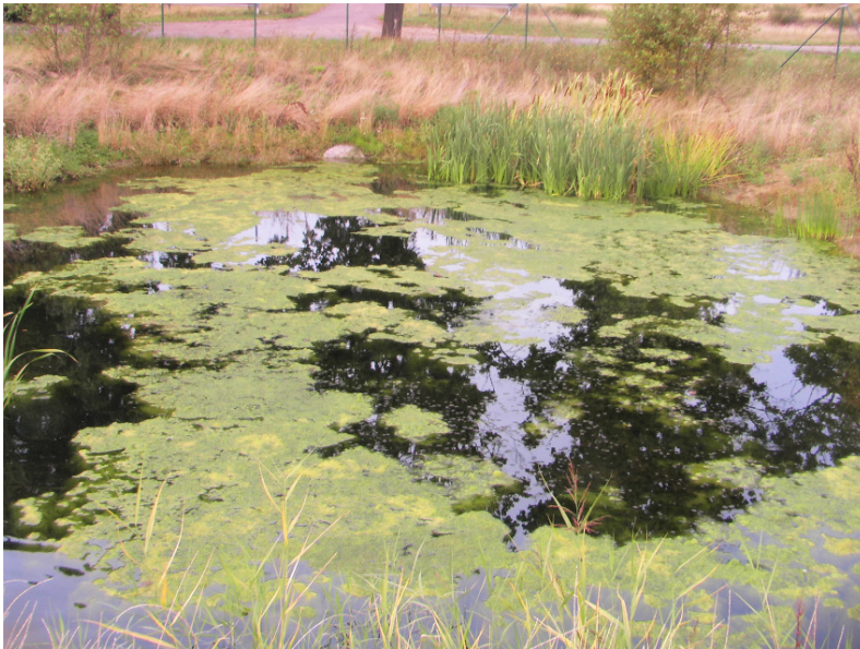
Überstautes Versickerungsbecken an der B189, 48 Stunden nach einem Starkregen
