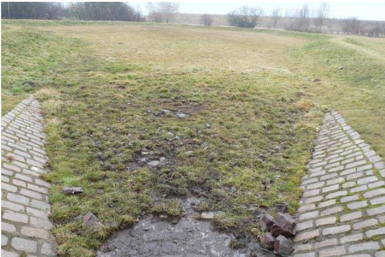
Versickerungsbecken kanalgespeist mit vorgeschaltetem Schachtsandfang
