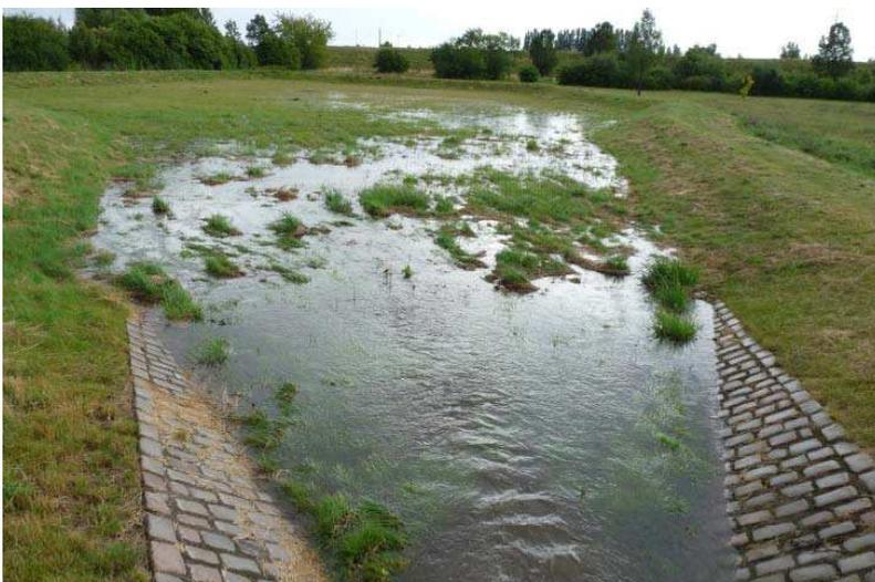
Befüllung des Versickerungsbeckens nach einem Starkregen (14 mm)
