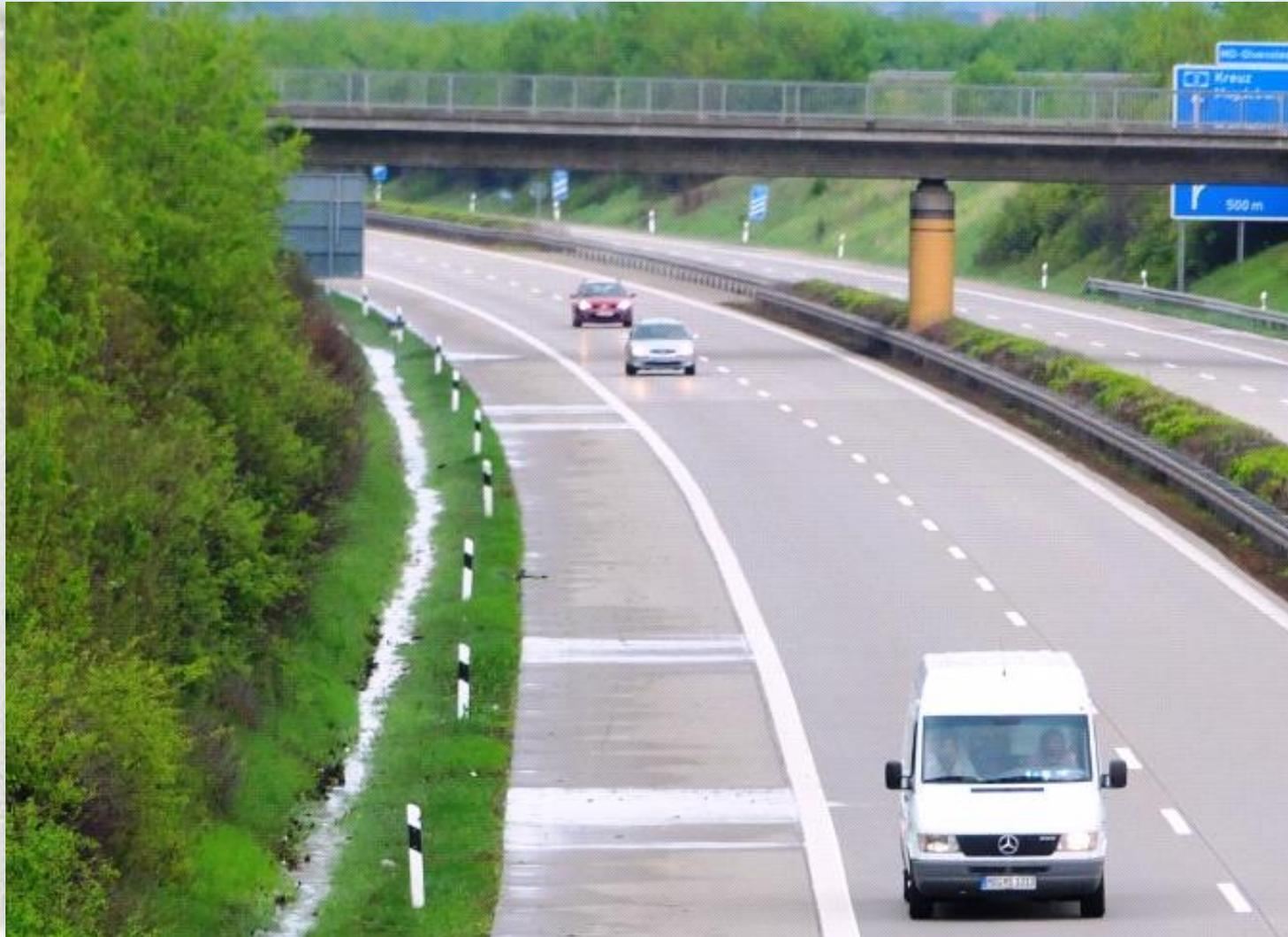
Muldenabfluss an der A 14 bei Magdeburg nach einem Starkregenereignis außerhalb der Bemessungshäufigkeiten mit Erosionserscheinungen auf den Ackerflächen neben der Autobahn
