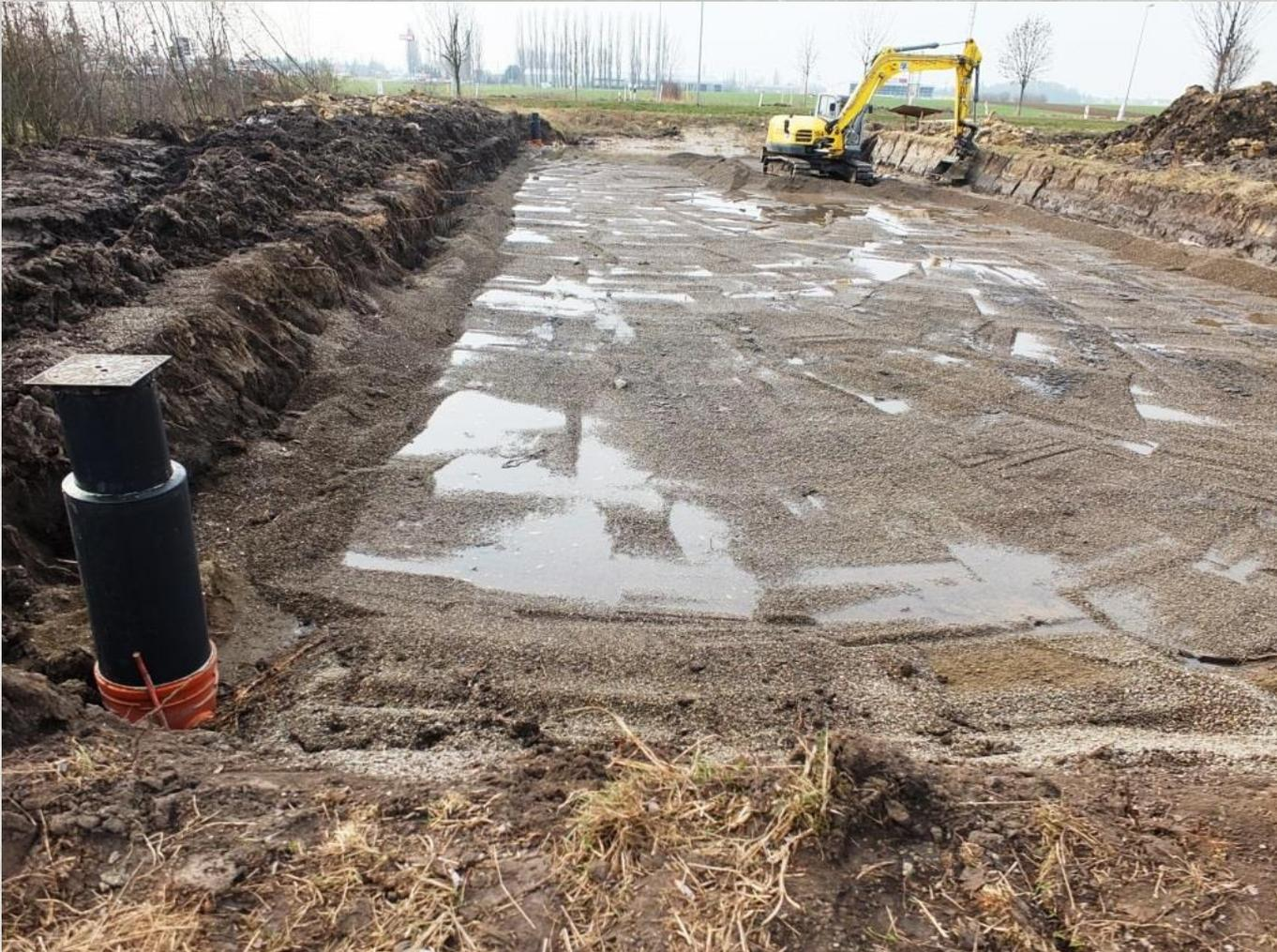
Musterbeispiel B1 Magdeburg mit vergleichbar geringen Aufbauhöhen: die neuen Böschungsdrainagen mit der Grunddrainschicht sind verlegt, aber noch nicht in Betrieb, da Anschluss fehlt, erfolgt noch kein Wasserabzug
