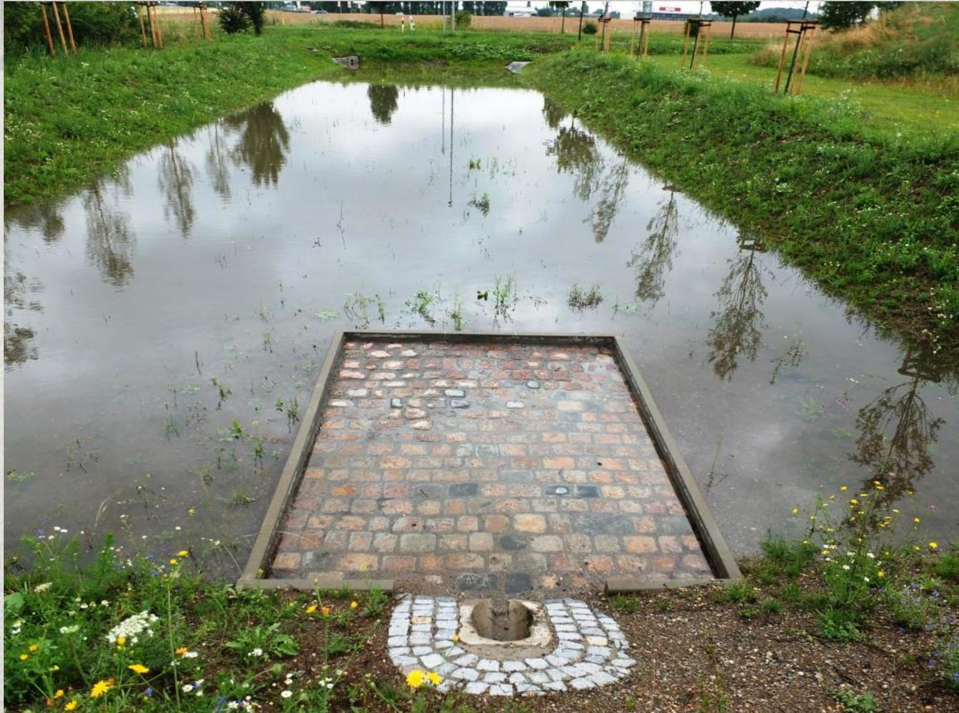
Blick über die Auslaufkonstruktion, Beckenwasserstand nach Starkregen, es erfolgte keine Inanspruchnahme der zweiten Staulamelle mit Drossel DN 300, sondern eine vollständige Filtration im Bodenfilter
