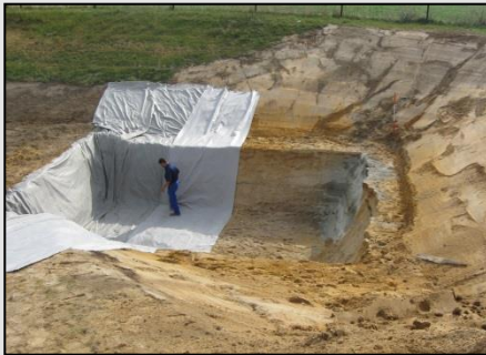
Herstellung von Sickerfenstern oder Sickerschlitz
