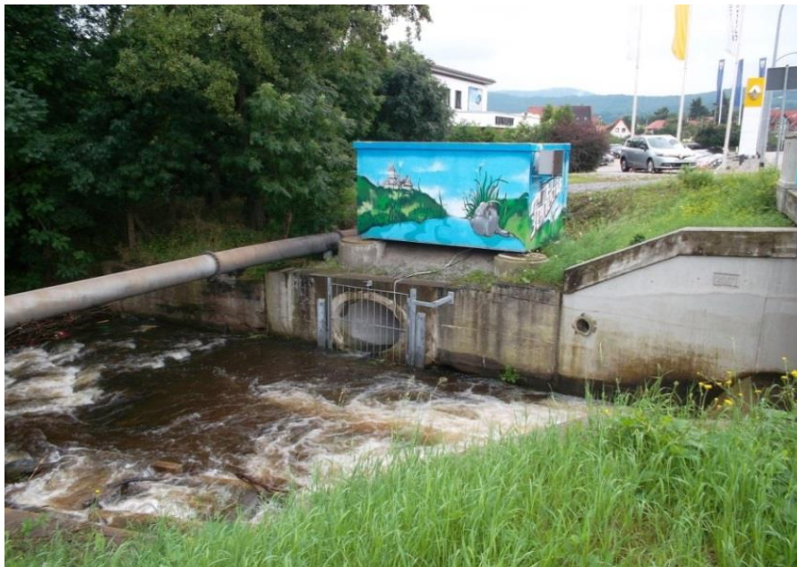
Messcontainer des LAU in Wernigerode
