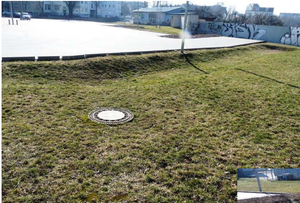
Parkplatzentwässerung mit geschlitzten Hochborden in flache Sickermulden einschl. hochgesetztem Muldenüberlaufschacht zur Wassereinstaubbegrenzung auf 20 cm
