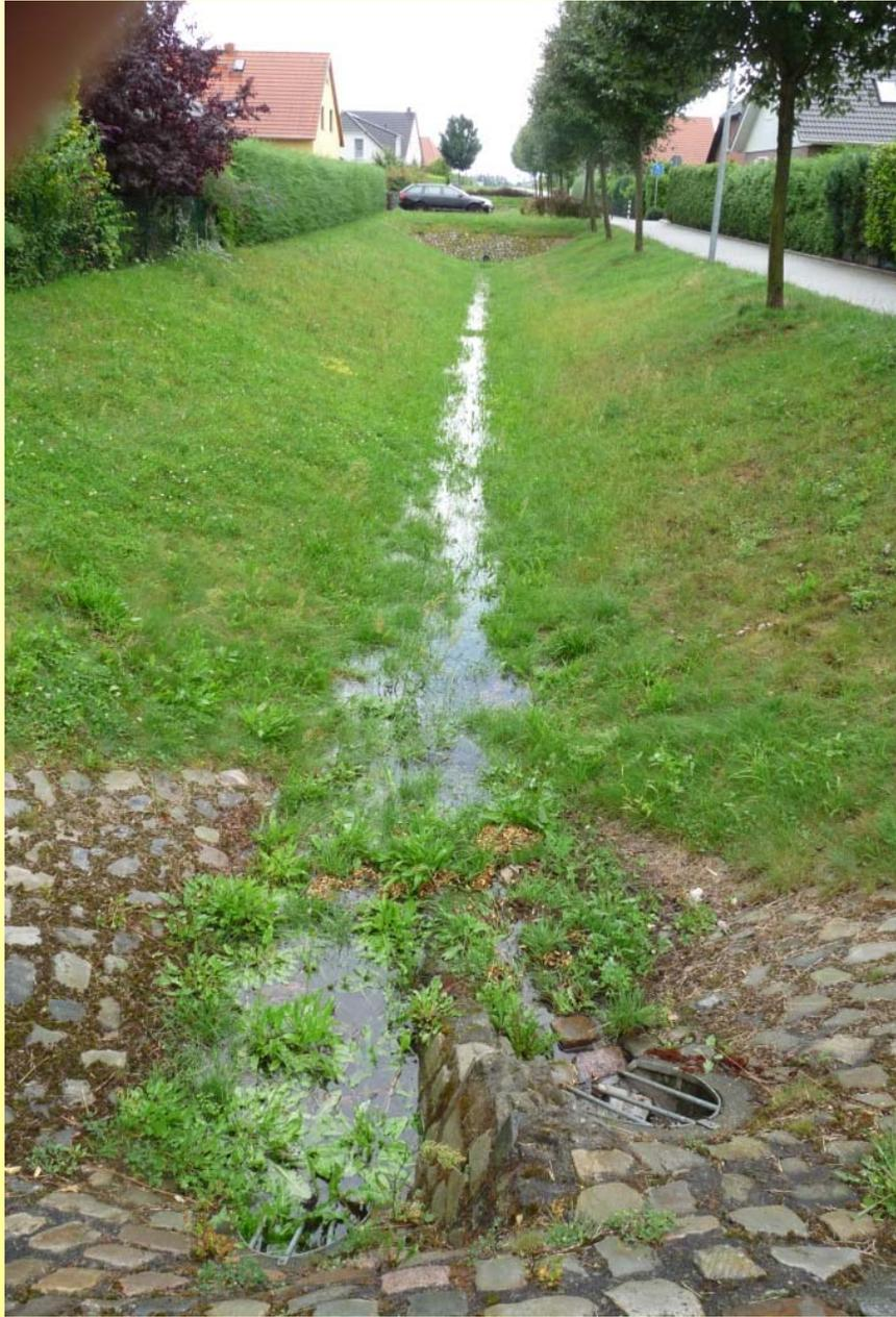
Abfluss eines Starkregen von 11 mm ( $n \sim 0,33 \text{ a}^{-1}$ ) im Wohngebiet (Straßen und Gehwege) mittels Mulde
