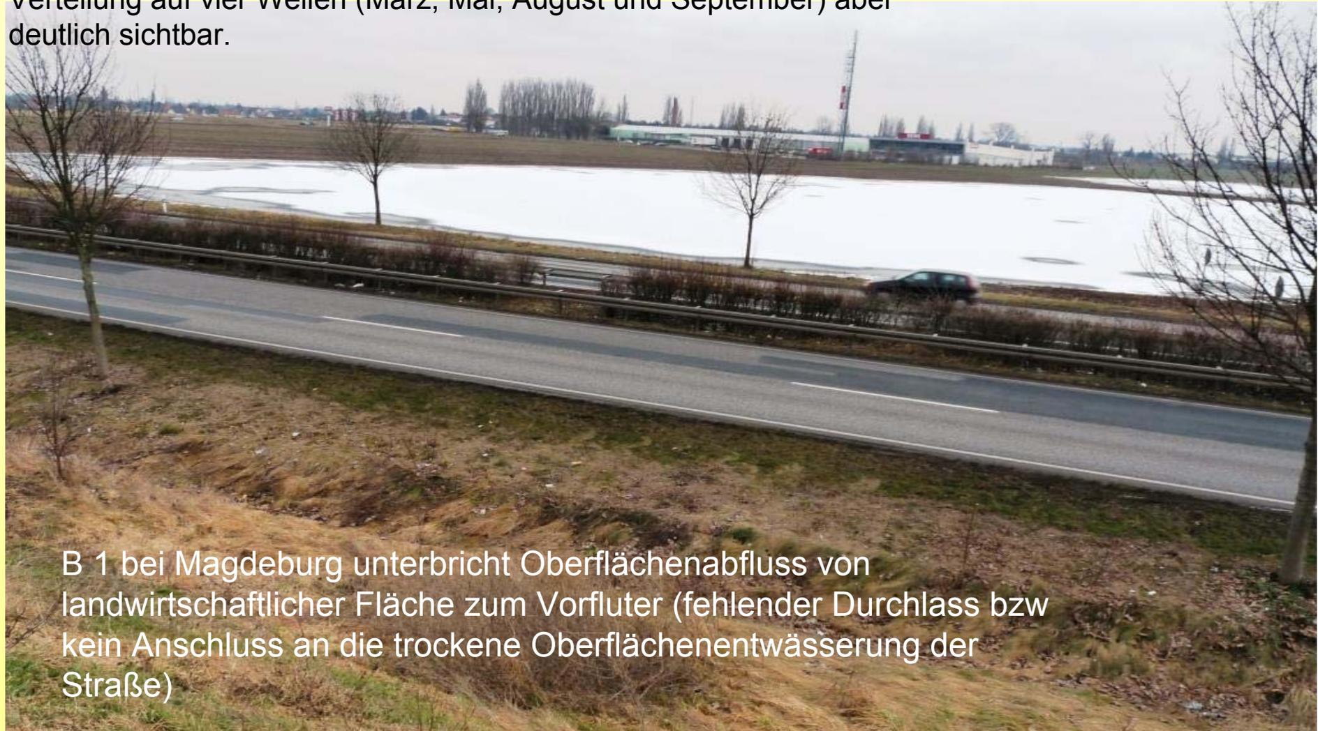
B 1 bei Magdeburg unterbricht Oberflächenabfluss von landwirtschaftlicher Fläche zum Vorfluter (fehlender Durchlass bzw kein Anschluss an die trockene Oberflächenentwässerung der Straße)
