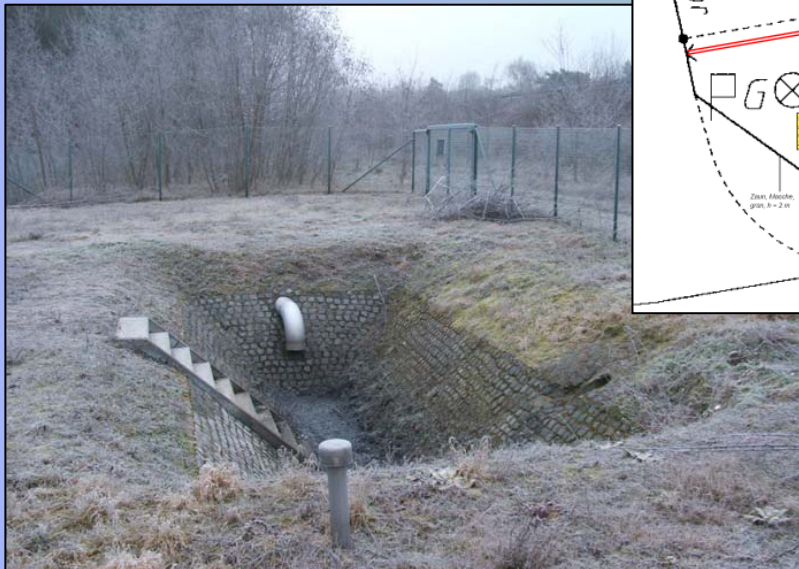
Bestand vor dem Umbau
