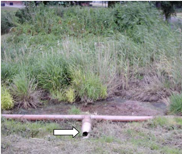
Abb. 4.2-2: PKA Geestgottberg – beschädigte Beschickungseinrichtung und Fremdpflanzen auf Beet 1 (LAU 07/2008)
