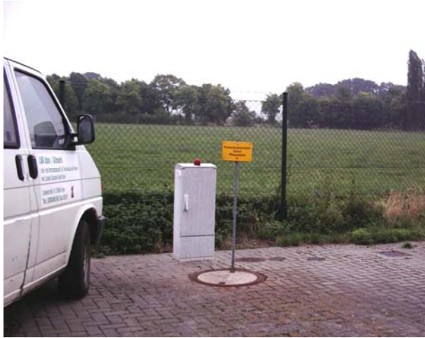
Abb. 2.1-3: PKA Iden - Probennahmestelle Vorklärung (LAU 07/2008)
