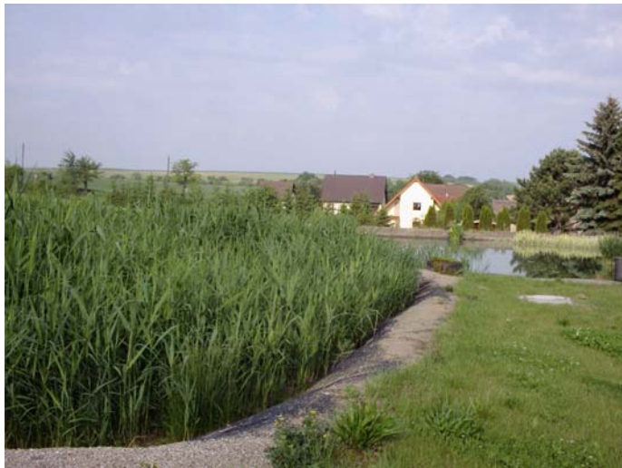
PKA Leimbach 2 – Gesamtansicht Pflanzenbeet mit Stapelteich im Hintergrund (LAU 05/2007)
