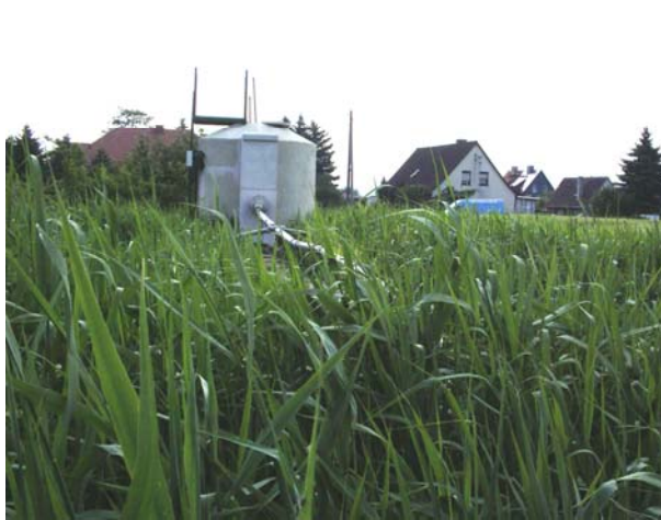
Abb. 2.2-3: PKA Leimbach 2 - Pflanzenbeete mit Beschickungsrohren und Hochbehälter im Hintergrund (LAU 05/2007)
