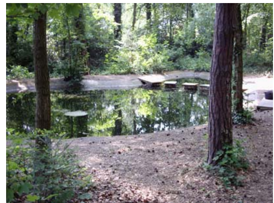
PKA Villa Jühling – Teich-Versickerungs- anlage (LAU 05/2007)
