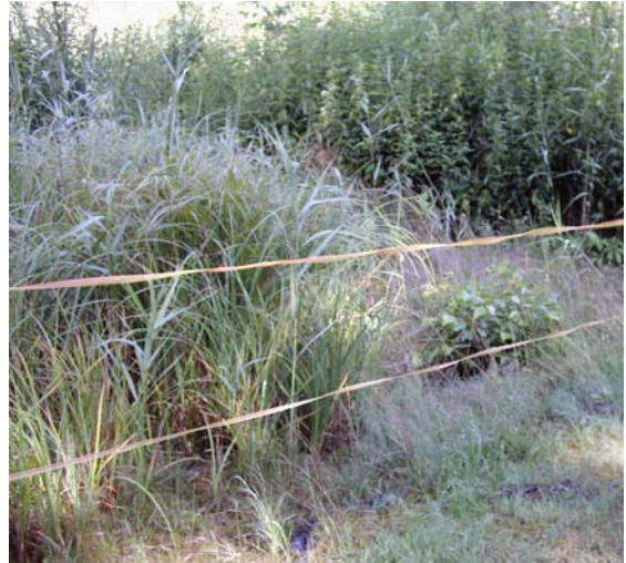
Abb. 4.2-10: PKA Buchholzmühle – Pflanzenbeet, stellenweise lückenhaftes Schilfwachstum und Fremdbewuchs, Pflanzenbeet zu trocken (LAU 07/2008)
