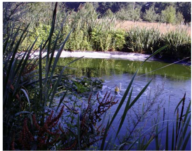
PKA Dietrichsdorfer Mühle – Schönungsteich mit Belüftung (LAU 07/2008)
