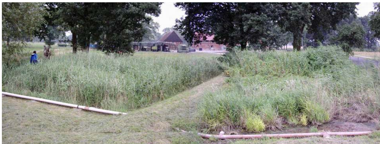
PKA Geestgottberg mit 2 Pflanzenbeeten (LAU 07/2008) und Beschickungseinrichtung
