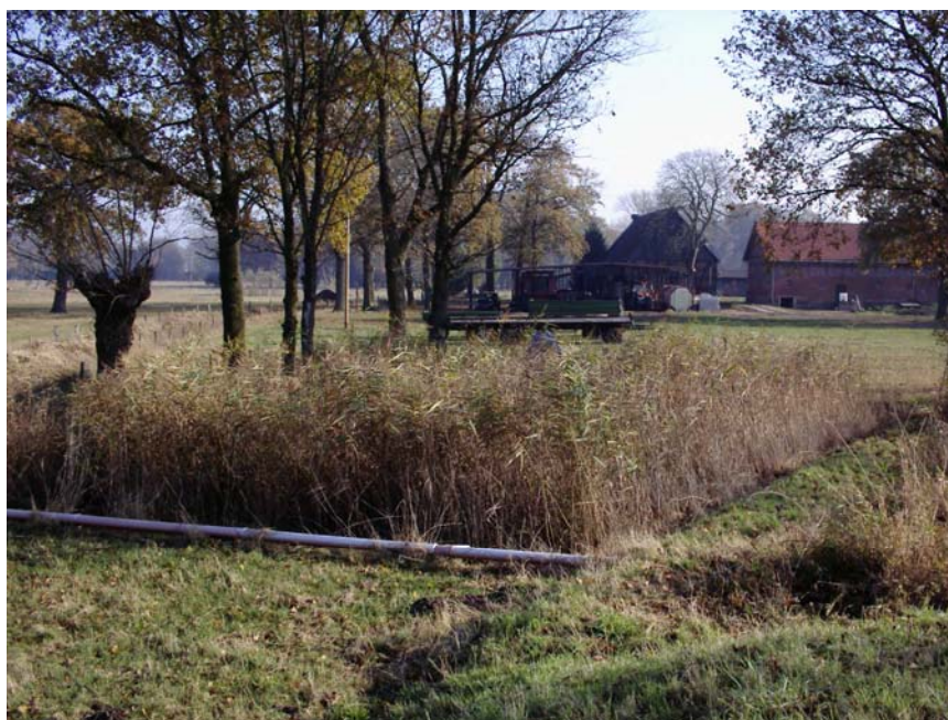
Abb. 4: PKA Geestgottberg –Pflanzenbeet Horizontalfilter, Kapazität 40 EW (LAU 2004)
