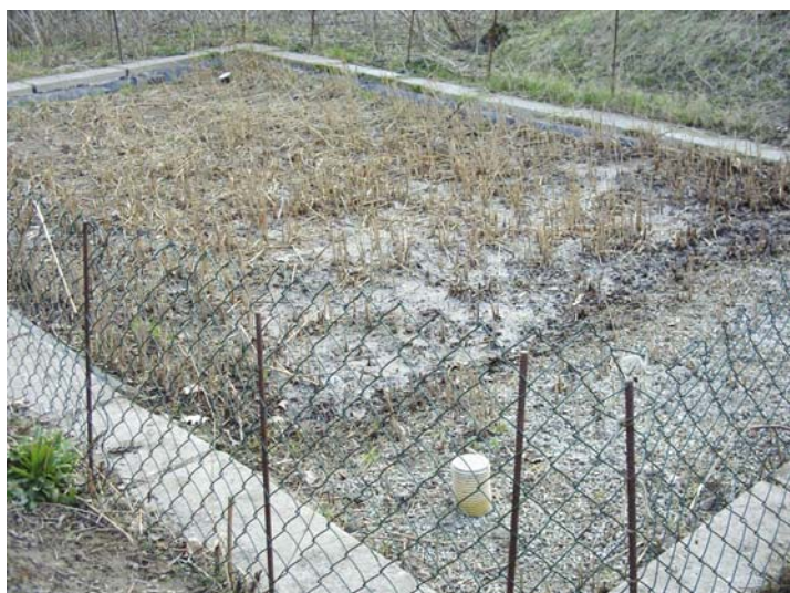
Abb.2 : PKA Janisroda – Pflanzenbeet im zeitigen Frühjahr, Einlaufbereich im Vordergrund (LAU 2005))
