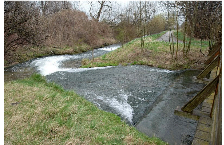
Sohlschwelle zum Wasserrückhalt
