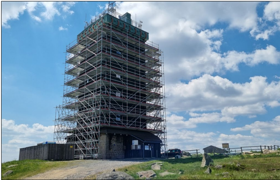
Abbildung 1: Messturm des Deutschen Wetterdienstes (DWD) auf dem Brocken mit Baugerüst, Foto LAU (13/06/2023)
