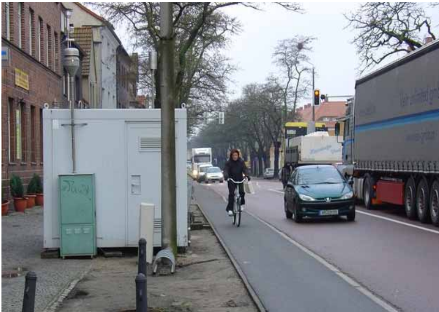
Abbildung 3.3.1: Lichtsignalanlage Dessauer Straße / Pestalozzistraße
