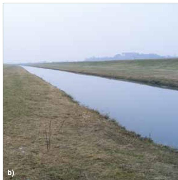
**Abb. 89:** Unterschiede der Uferbindung in den Biotopverbund an technisch überprägten Gewässern, Negativbeispiele: a) Neubau Spundwände Haldensleben unter Ausschluss der Biozönose, b) schutzlose Uferzonen durch fehlende Bepflanzung/Beschattung bei Wendelstein. Fotos: A. Weber
