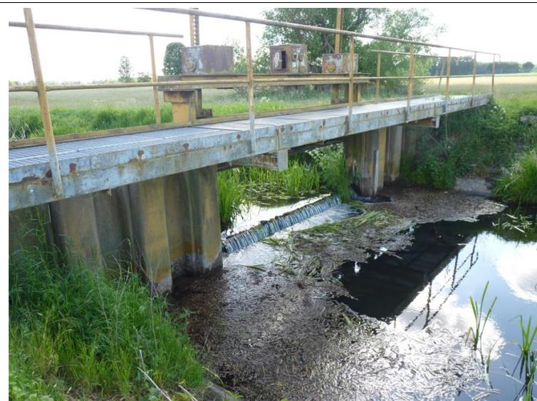
Foto 15: Stauanlage in der **Jeetze** zwischen Immekath und Ristedt mit Abschlag zum Jeetze-Beiläufer.
