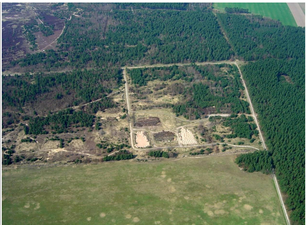
Foto 3 (oben): Die Calluna -Heiden setzen sich auch außerhalb des FFH-Gebietes fort und sollten im Rahmen einer Gebietserweiterung einbezogen werden (Flächen im Bildvordergrund). Foto 4: Durch ehemalige Bebauung und ungeordnete Ablagerungen geprägter Bereich – aktuell geeignet für Installation schäferereicher Infrastruktur.
