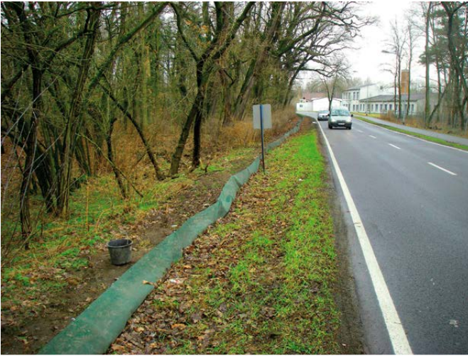
Abb. 4: Über 300 m langer mobiler Amphibien-Schutzzaun an der Belziger Chaussee in Wittenberg (Foto: U. ZUPPKE).
