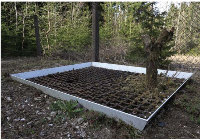
Abb. 5: Schachtkrone der Grube Büchenberg/Harz mit amphibiensicherer Abschirmung (Foto: A. WESTERMANN).
