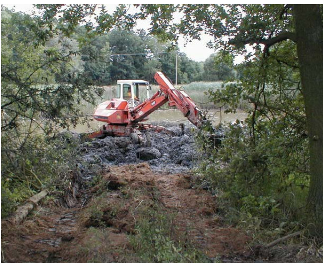
Abb. 2: Teichentschlammung mit Hilfe eines Schreitbaggers bei Kleindröben (Foto: B. SIMON).
