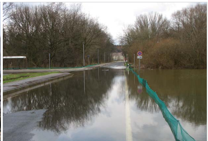
Abb. 3: Amphibienschutzanlage Zschwitz im Saalekreis beim Frühjahrshochwasser 2006 (Foto: W.-R. GROSSE).
