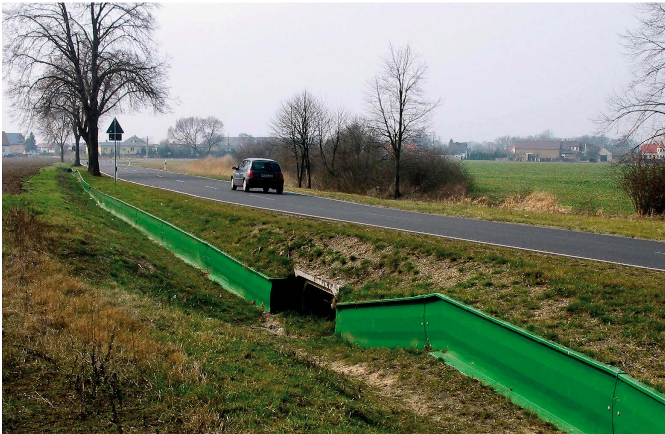
Abb. 6: Stationäre Amphibien-Schutzanlage mit Amphibientunnel bei Seegrehna, Lkrs. Wittenberg (Foto: U. ZUPPKE).
