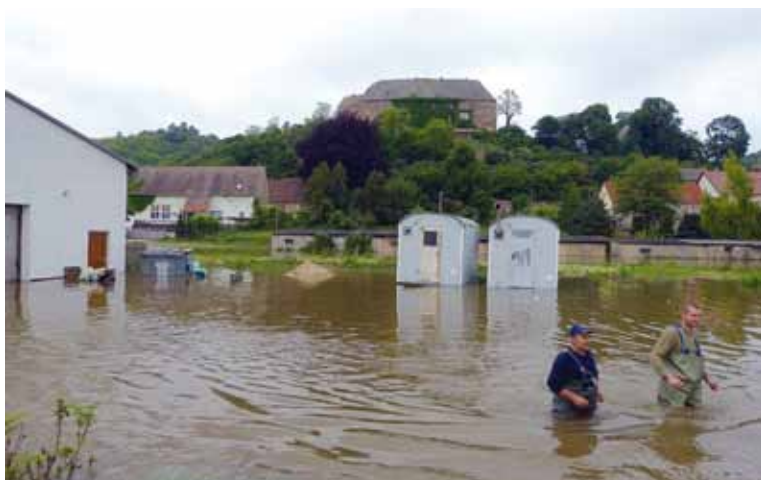
„Land unter“ – hieß es in Friedeburg – nur noch mit Wathose oder Schlauchboot kamen Helfer und Einheimische im Ort überhaupt vorwärts – die von Wasser angerichteten Schäden sind immens.
