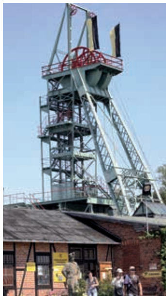
Weithin sichtbar ist das Wahrzeichen des Schaubergwerkes Wettelrode.
