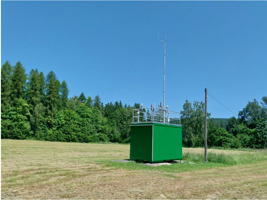
Abbildung 2: Messstation Unterharz/Friedrichsbrunn nach Hüllentausch, Foto LÜSA (06/2025)
