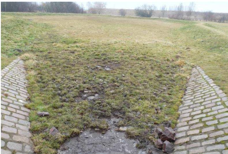
Versickerungsbecken kanalgespeist mit vorgeschaltetem Schachtsandfang
