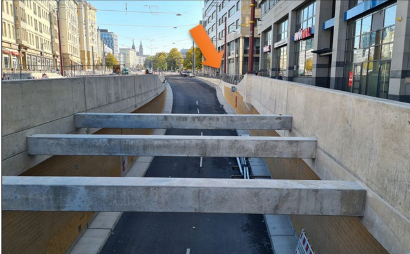
Abbildung 2: Ernst-Reuter-Allee, östliche Tunnelausfahrt, Pfeil weist auf den Standort der Sondermessstation, Foto LAU (29/09/2022)
