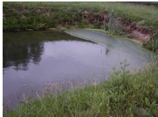
Abb. 4 : Absetzteich zur Vorklärung bei einer kleinen Kläranlage
