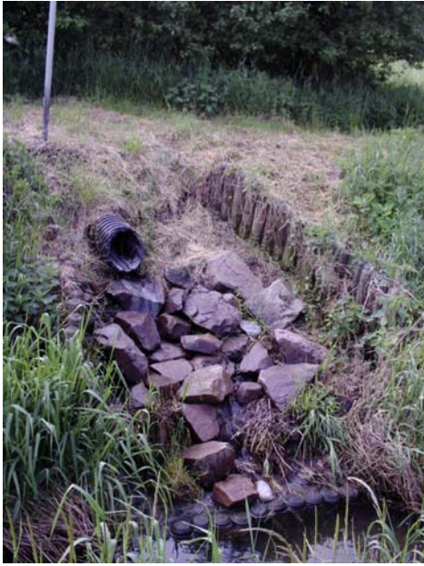
Abb. 10: Einleitungsbauwerk - Einleitung in ein Fließgewässer
