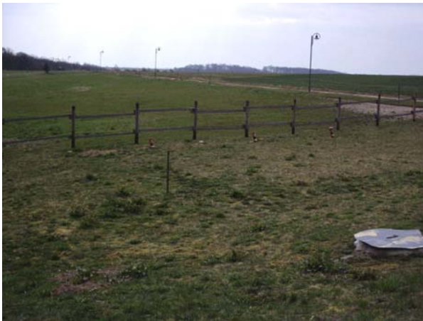
Abb. 12: Versickerungseinrichtung - Einleitung in den Untergrund (Rohr-Rigolen-Versickerungsanlage)
