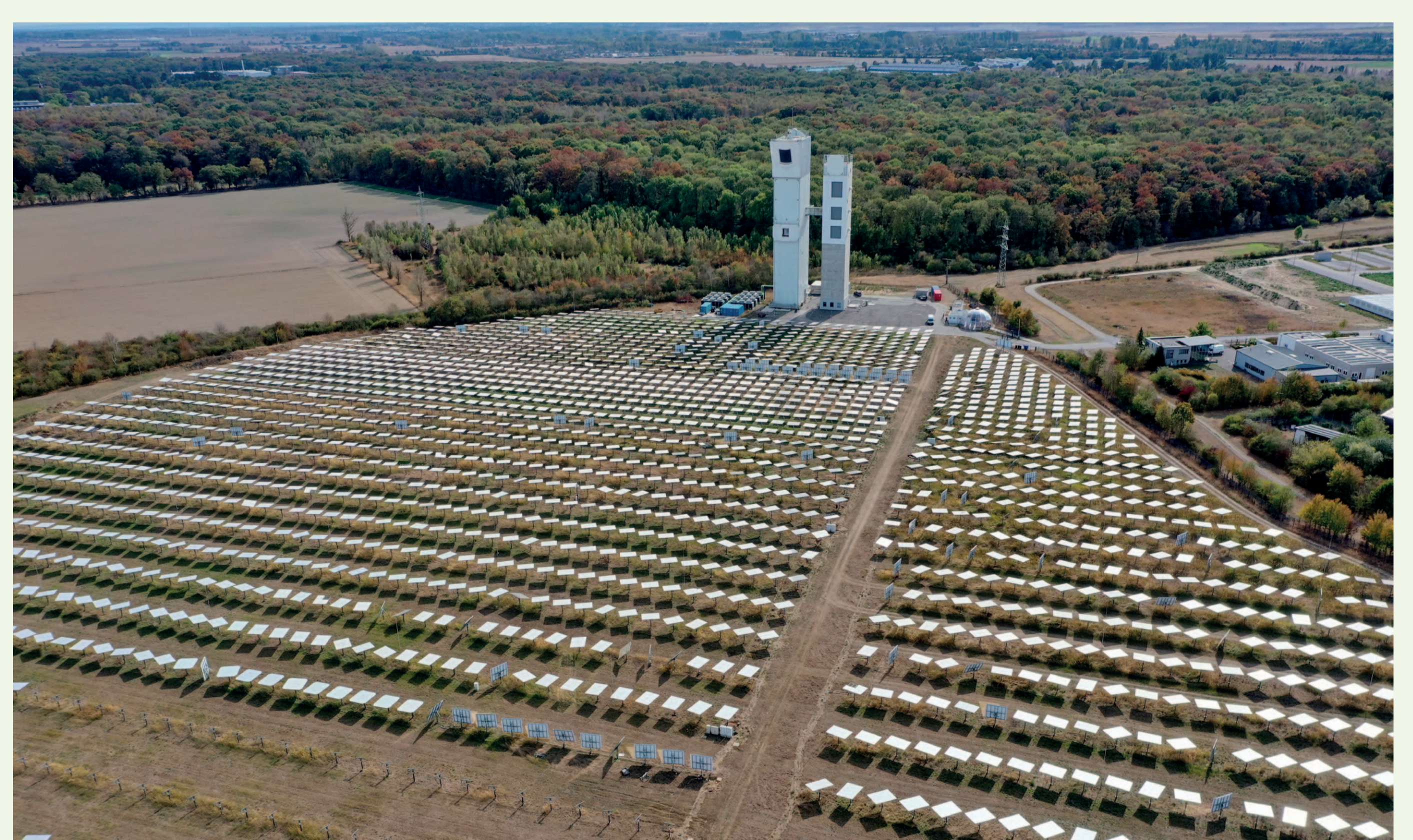
Bild: Solarthermisches Versuchskraftwerk und Multifokusturm Jülich Quelle: Deutsches Zentrum für Luft- und Raumfahrt – Institut für Solarforschung
