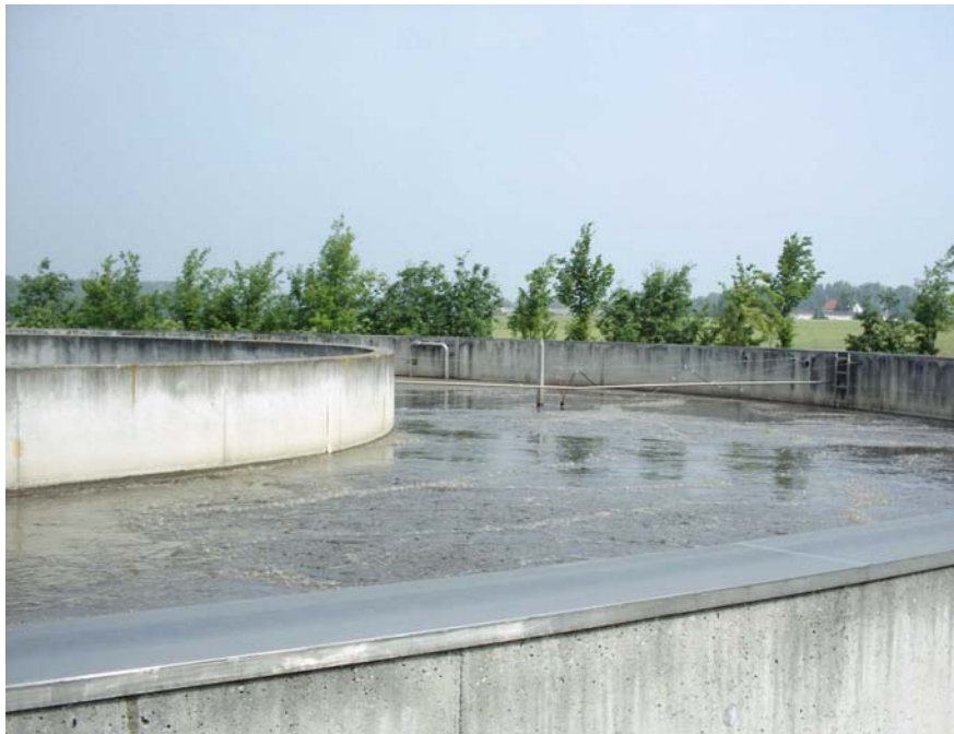
Abb. 3: Belebungsbecken KA Zörbig
