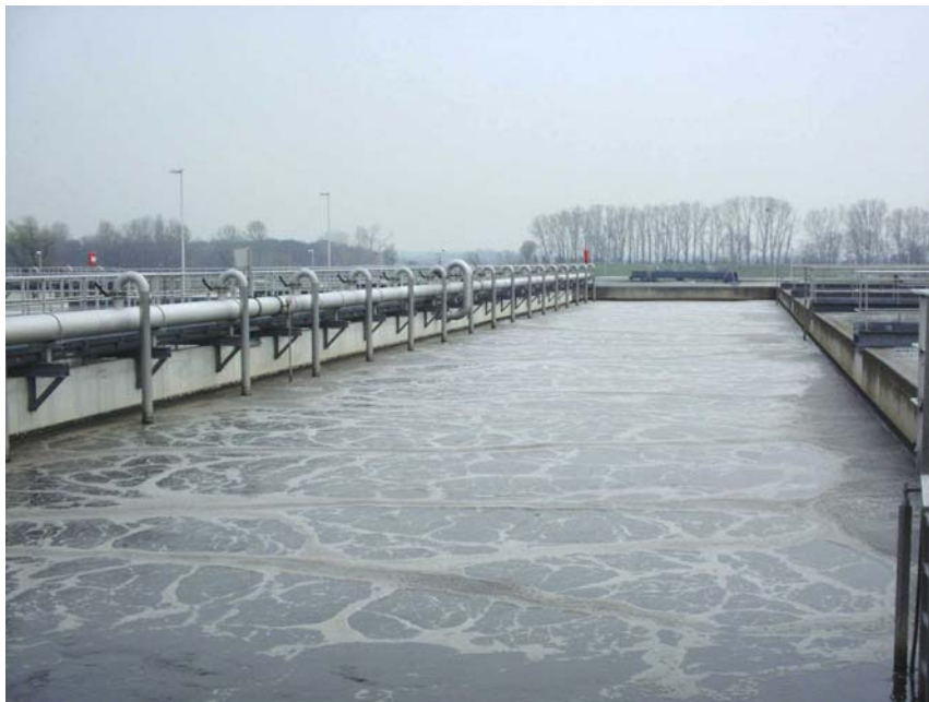
Abb. 1: Belebungsbecken KA Magdeburg-Gerwisch
