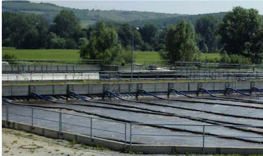
Abb. 2: Belebungsbecken KA Laucha
