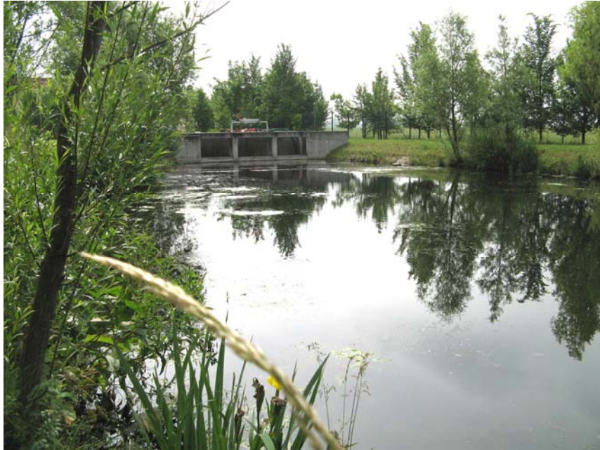
Abb. 4: Nachklärteich KA Zörbig, im Hintergrund Ablaufbauwerk
